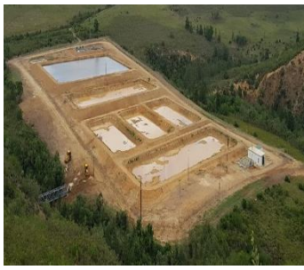
Suurbraak Oxidation dams
